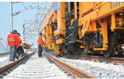
4月11日,在福厦高铁莆田站,作业人员对最后900米有砟轨道精细调整结束,福厦高铁全线轨道精调顺利完成。新华社记者林善传摄
