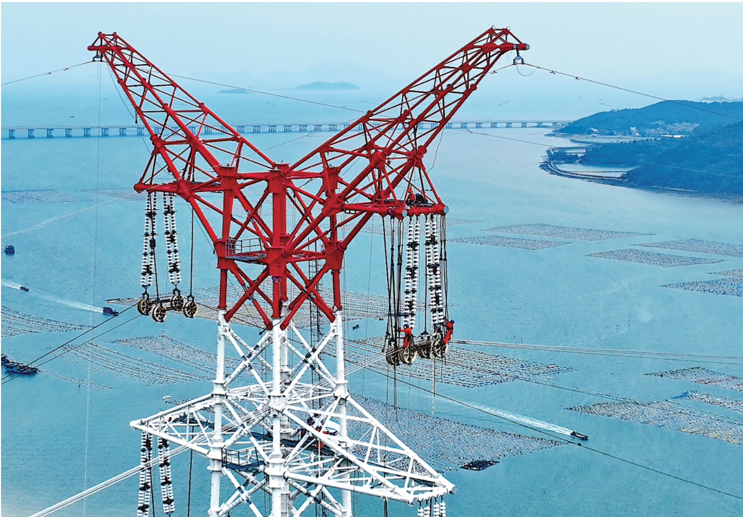
▲3月31日,施工人员在电力钢管塔上作业(无人机照片)。当日,在福建漳州核电500千伏送出工程施工现场,施工人员在横跨1500米的漳江跨越线路百米上空进行四回线路同时跨江作业,全力推进工程进度。 新华社记者林善传摄
