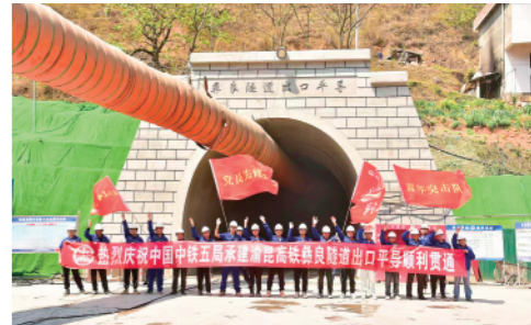
渝昆高铁最长隧道彝良隧道出口平导于4月1日贯通,实现关键性节点突破。新华社发
