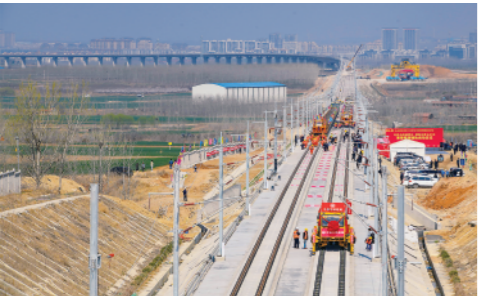
4月1日,位于山东省胶东半岛东南部沿海地区的莱荣铁路正式进入全线铺轨阶段。新华社记者朱峥摄
