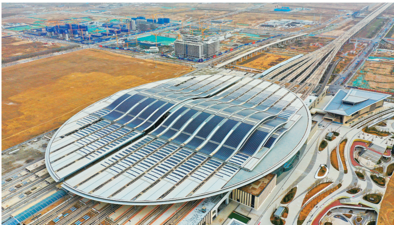
▲京雄城际铁路雄安站(三月二十三日摄)。新华社记者牟宇摄
