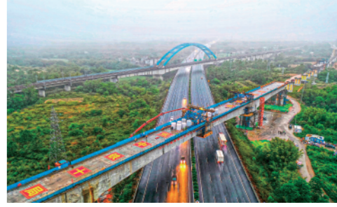
3月29日晚，广(州)湛(江)铁路长兴村特大桥跨G15沈海高速连续梁顺利合龙。新华社记者刘大伟摄
