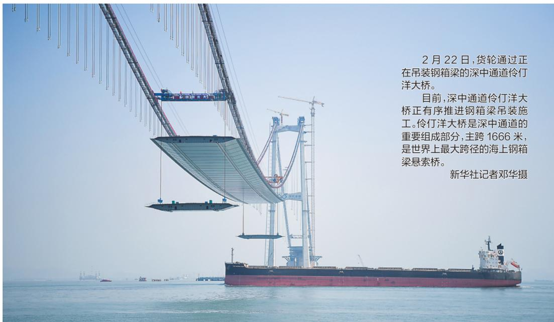
2月22日，货轮通过正在吊装钢箱梁的深中通道伶仃洋大桥。
