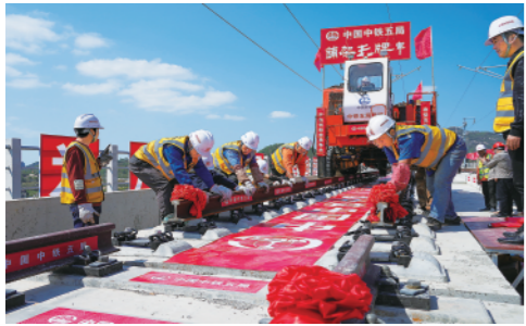
2月23日,广汕铁路正线最后一组500米长轨在汕尾东冲特大桥铺设完成,该线正线铺轨实现贯通。新华社记者刘大伟摄
