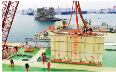
近日,渤海油田渤中19-6凝析气田一期开发项目CEPA(中心处理平台)组块在青岛完成封顶工作。新华社记者李紫恒摄
