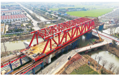
2月19日拍摄的常(州)泰(州)长江大桥南北公路接线工程跨G345特大桥钢桁梁顶推作业现场。 新华社记者季春鹏摄
