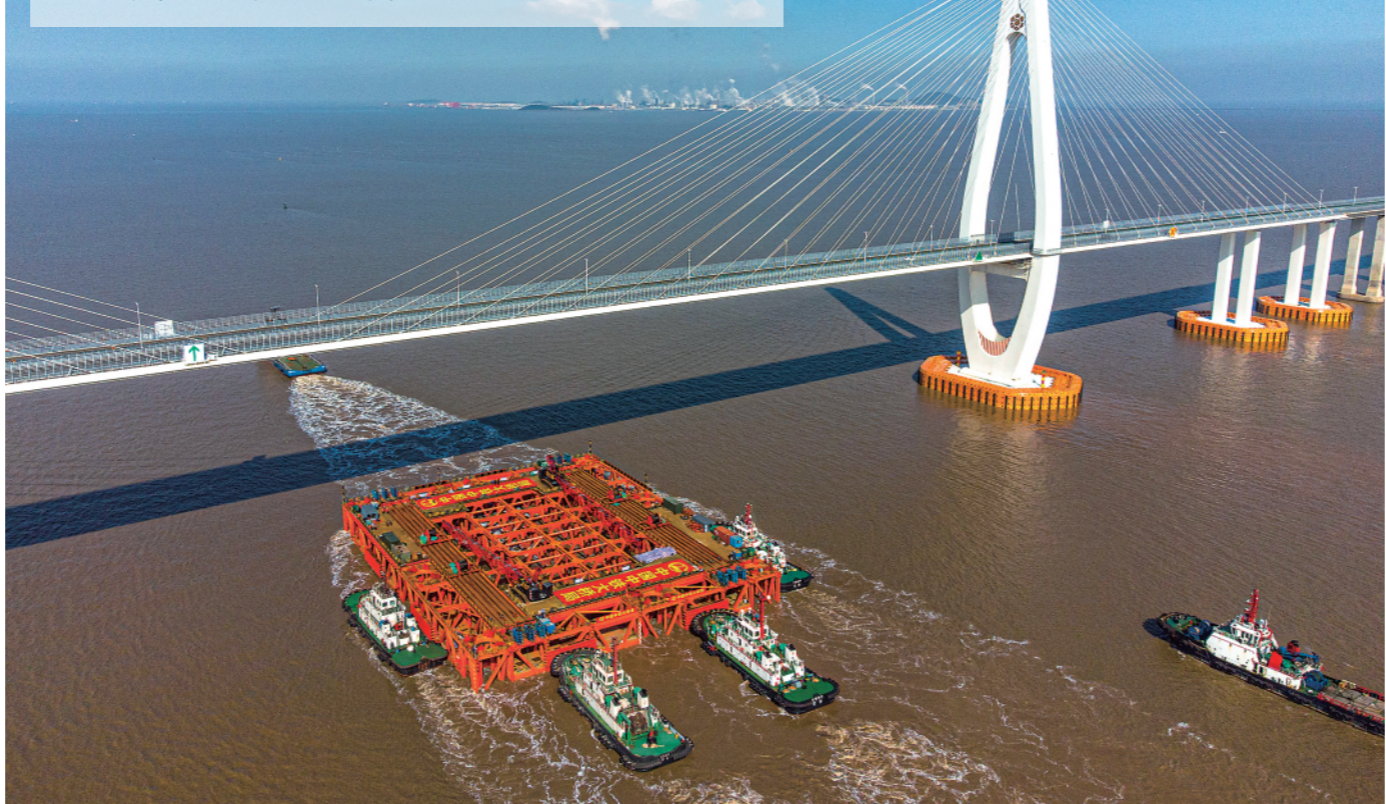
二月十六日，甬舟铁路西堠门公铁大桥五号墩自浮式钻孔平台通过舟岱大桥主通航孔浮运到位，标志着大桥主塔墩基础建设拉开序幕。西堠门公铁两用大桥是甬舟铁路及甬舟高速公路复线跨越西堠门水道的共用跨海桥梁，连接舟山金塘岛和册子岛，是全线的控制性工程。新华社发(姚凯乐摄)
