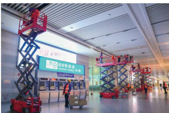
▲2月7日,在上海虹桥火车站,上海房建公寓段工作人员在更换站内的筒灯。春运期间,中国铁路上海局集团有限公司上海房建公寓段积极开展房建设备检修工作,确保春运铁路运输安全。
