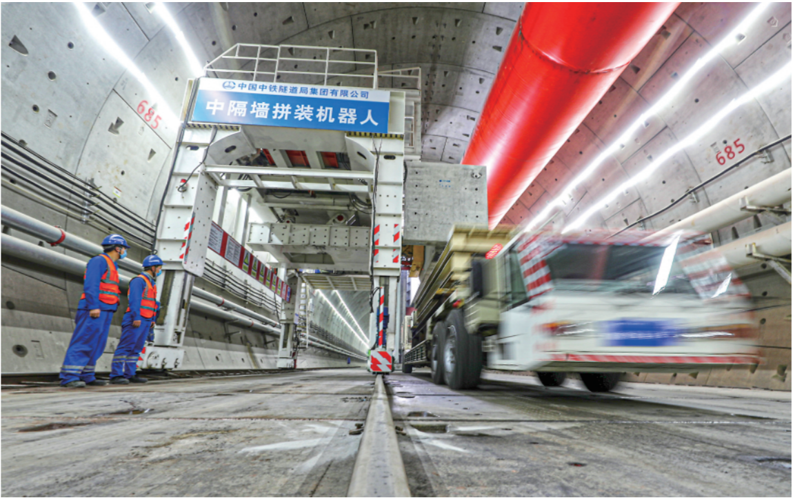
▲在中铁隧道局上海市域铁路机场联络线11标项目施工现场，一辆新能源双头车从中隔墙拼装机器人旁驶过(1月6日摄)。近期，中铁隧道局上海市域铁路机场联络线11标项目施工现场一派忙碌，工程技术人员运用多种自主研发的智能设备开展施工。上海市域铁路机场联络线于2019年6月开工，项目建成后，上海虹桥和浦东两大综合交通枢纽间通行时间可控制在40分钟之内。
