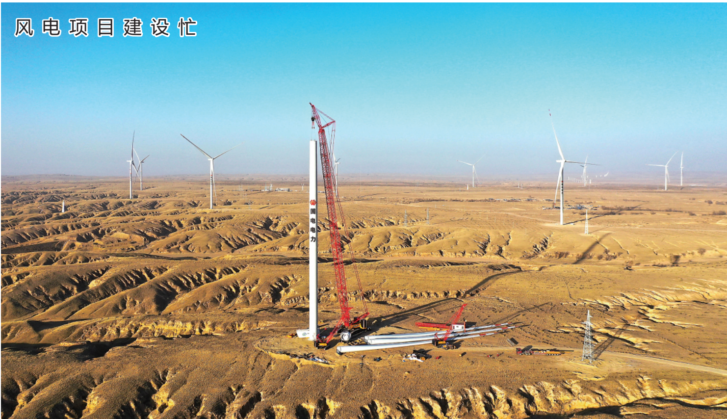
▲这是国电电力达拉特旗20万千瓦风电项目。目前,国电电力达拉特旗“黄河流域生态保护和高质量发展”20万千瓦风电项目正在建设中。该项目位于内蒙古达拉特旗昭君镇,建成后预计年发电量5.48亿千瓦时。 新华社记者刘磊摄
