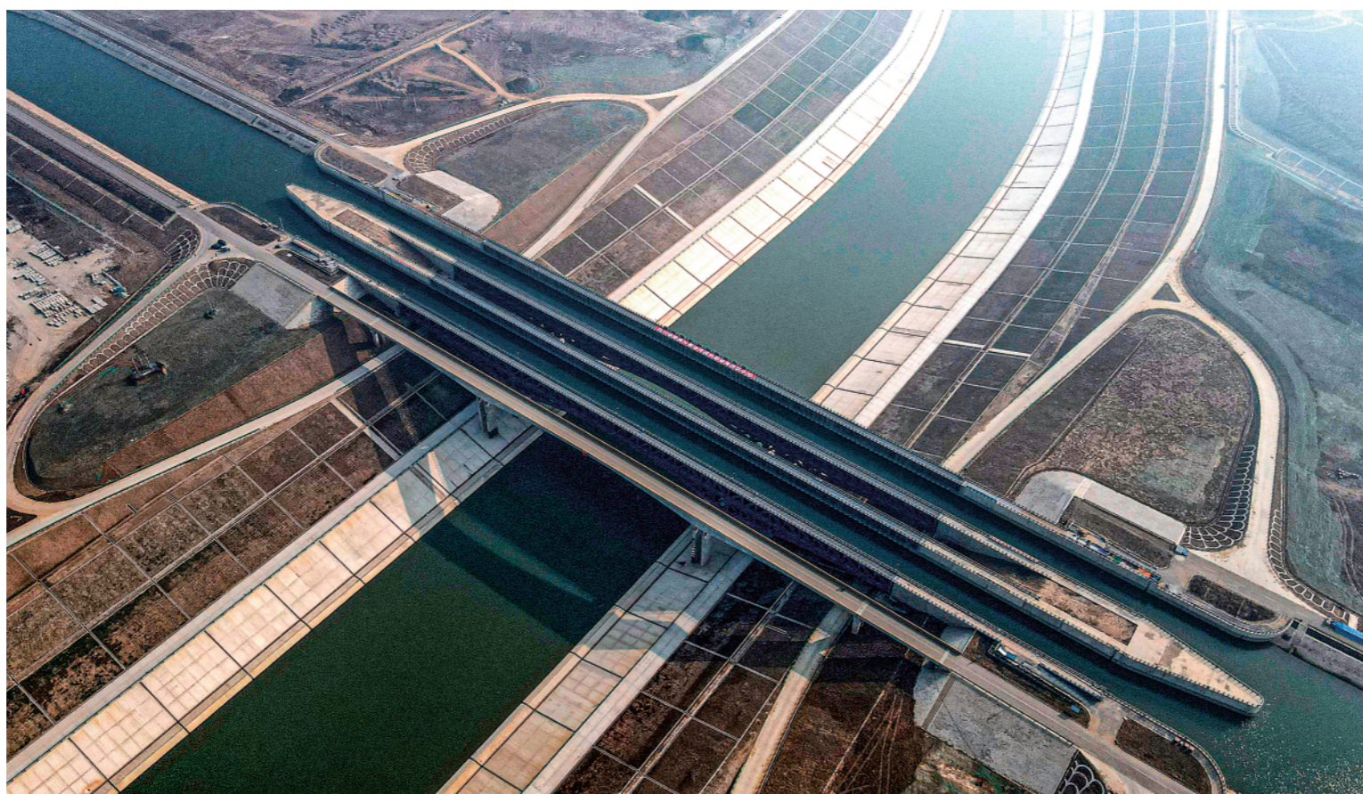
▲12月30日，中铁四局参建的引江济淮淮河总干渠渡槽通航。淮河总干渠从引江济淮运河上凌空而过，呈现出出河上有河的“水上立交”景象。
