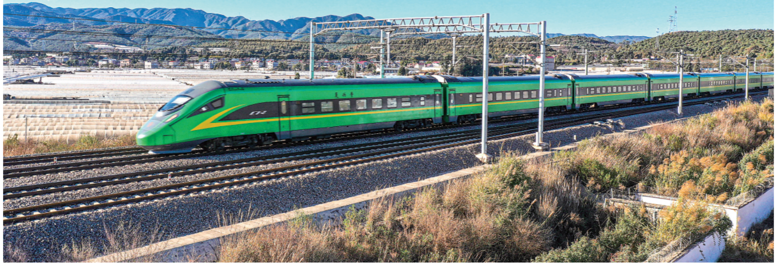
▲一辆“复兴号”列车行驶在中老铁路昆明市晋宁区内(2022年12月2日摄)。
