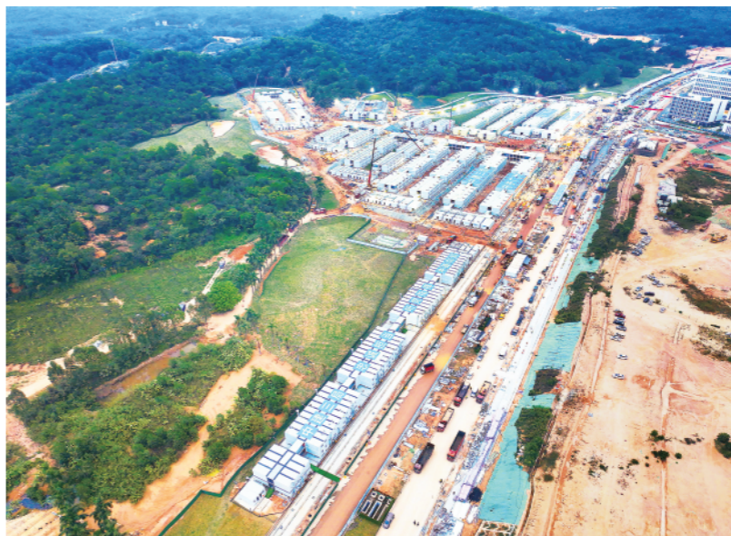
▲这是11月21日拍摄的广州黄埔区中新知识城方舱医院项目（无人机照片）。 新华社发
