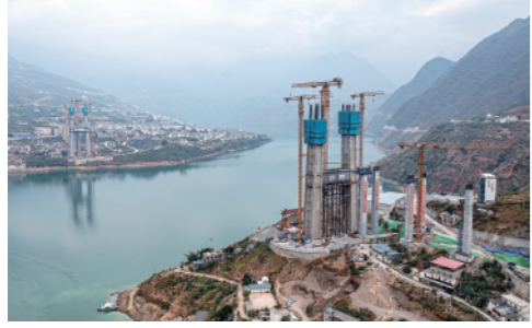
目前,卡哈洛金沙江大桥建设有序推进,大桥将成为连接四川沿江高速和云南大永高速的主要通道(11月23日摄)。新华社记者胥冰洁摄
