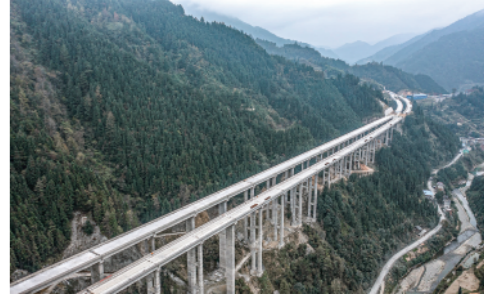
贵州雷山至榕江高速公路建设项目在确保安全的前提下,正加紧施工,抢抓项目建设进度(11月15日摄)。新华社记者陶亮摄
