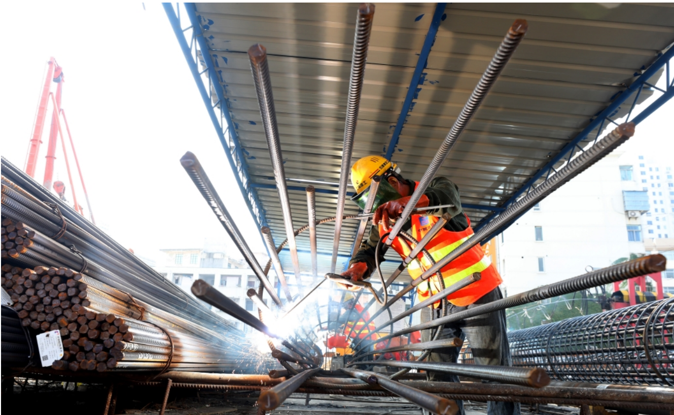
▲十月一日,位于上海市静安区的中建二局静安谈家桥城市更新项目工地,电焊工在进行地基工程桩焊接作业。 新华社记者方喆摄
