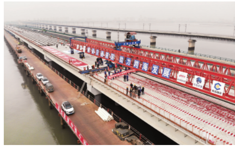
10月30日,青兰高速双埠至河套段女姑口特大桥顺利合龙,标志着青兰高速改扩建工程跨海段全线贯通。新华社记者李紫恒摄
