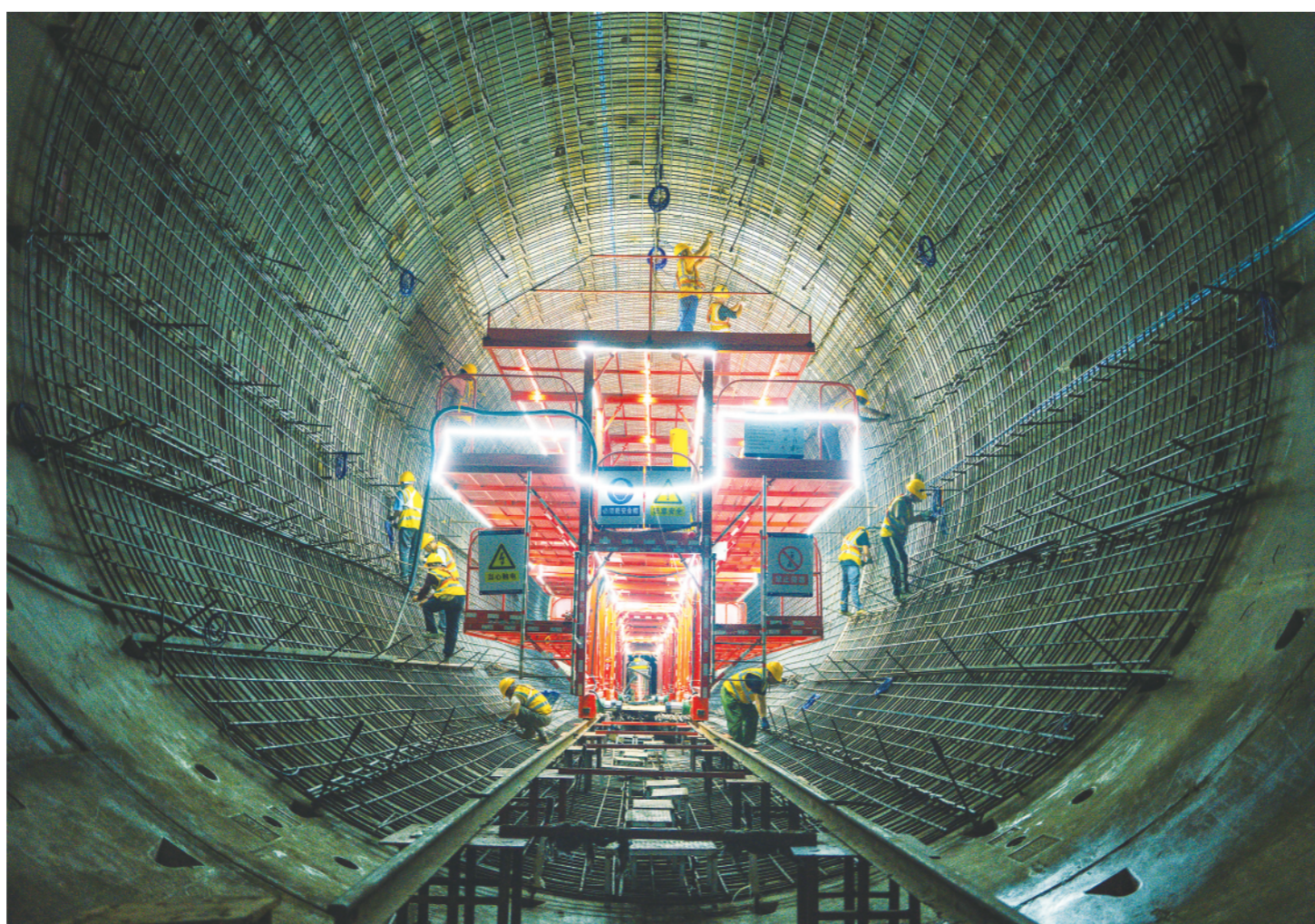
▲这是珠三角水资源配置工程施工现场(资料照片)。
