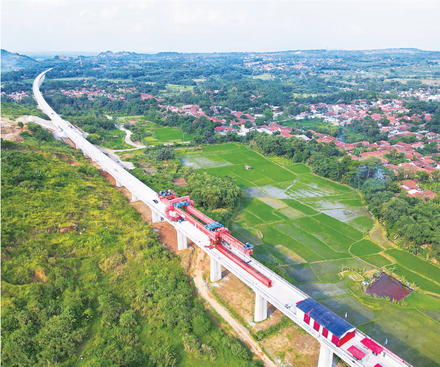
▲这是 10 月 16 日在印度尼西亚西爪哇省普哇加达县拍摄的雅万高铁全线最后一榀梁架施工现场。随着雅万高铁全线箱梁架设任务顺利完成，铺轨通道全面打通，为 2023 年 6 月建成通车奠定了坚实基础。雅万高铁连接印尼首都雅加达和第四大城市万隆，是中国高铁首次全系统、全要素、全产业链在海外建设项目，也是“一带一路”倡议和中印尼两国务实合作的标志性项目。
