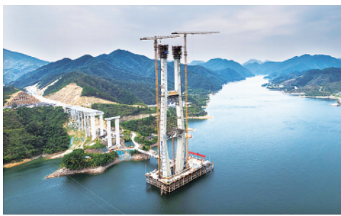
9月20日,官(庄)新(化)高速全线重点控制性工程马路口资水特大桥主墩封顶。 新华社记者陈思汗摄
