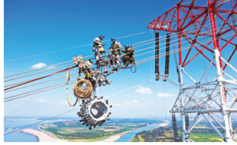
9月16日,白鹤滩至浙江±800千伏特高压直流输电工程(白浙线)安徽段顺利完成长江大跨越放线作业。新华社发(赵献富摄)
