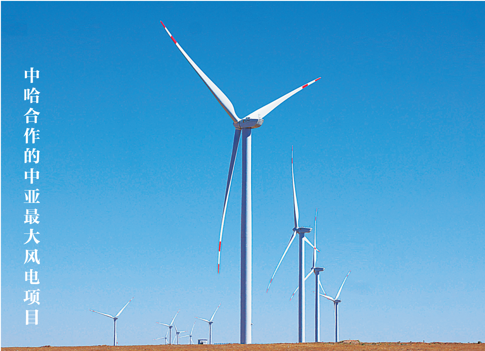
▲这是9月13日拍摄的哈萨克斯坦札纳塔斯风电场风机。札纳塔斯100兆瓦风电项目由中国电力国际有限公司和哈萨克斯坦维索尔投资公司共同投资，中国水电建设集团国际工程有限公司承建，中国电建集团成都勘测设计研究院有限公司总包实施，共建有40台2.5兆瓦的风电机组，是中哈合作的中亚最大风电项目。项目每年可发电约3.5亿千瓦时，相比同等容量的火力发电每年可节约标准煤约11万吨。该风电场的投产对改善哈南北电力供需不均的状况具有重要战略意义。
