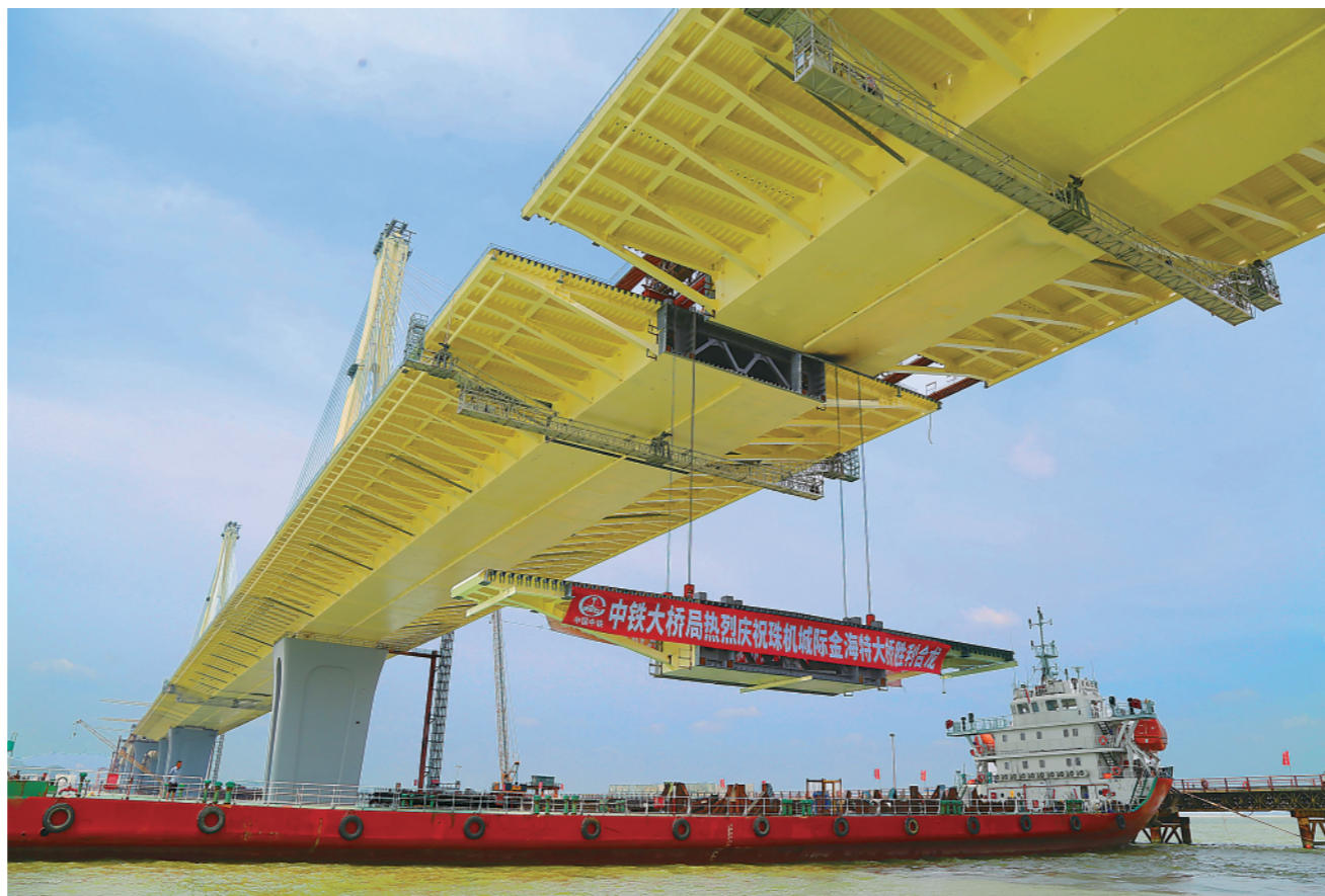
▲合龙中的珠机城际金海特大桥(9月4日摄)。
