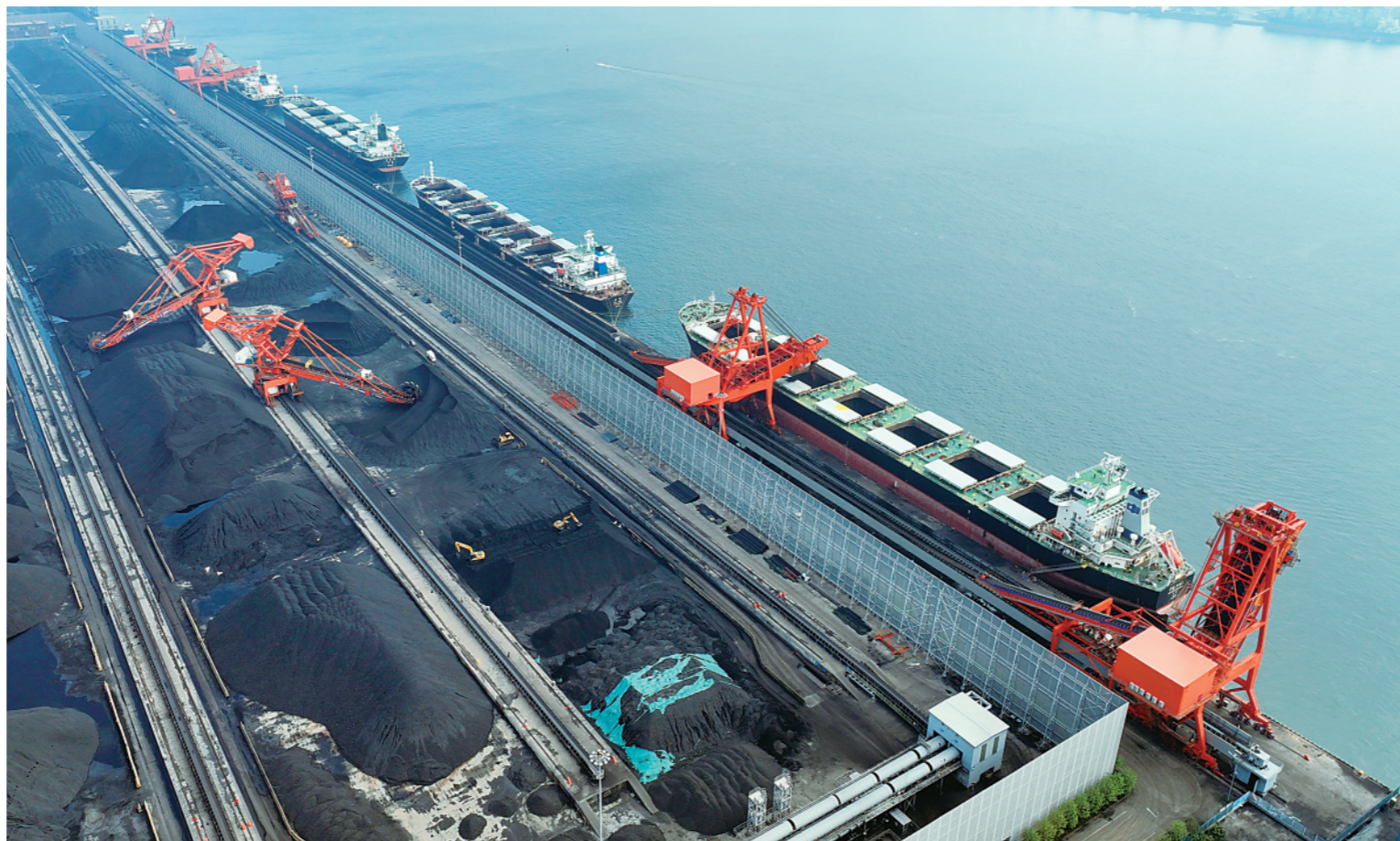
▲ 8月25日，在唐山港曹妃甸港区，装船机在进行煤炭装船作业。为进一步提高电煤运输效率，持续做好能源运输保障，河北曹妃甸海事部门建立相应的合作保供机制，保障电煤储运码头企业安全、高效运转，最大限度缩短电煤船舶滞港时间，集中力量保障能源物资海运通道安全畅通。自今年6月份以来，曹妃甸海事局共保障唐山港曹妃甸港区电煤运输船舶安全航行2238艘次，运送煤炭4442.89万吨，全力做好“北煤南运”能源运输保障工作。
