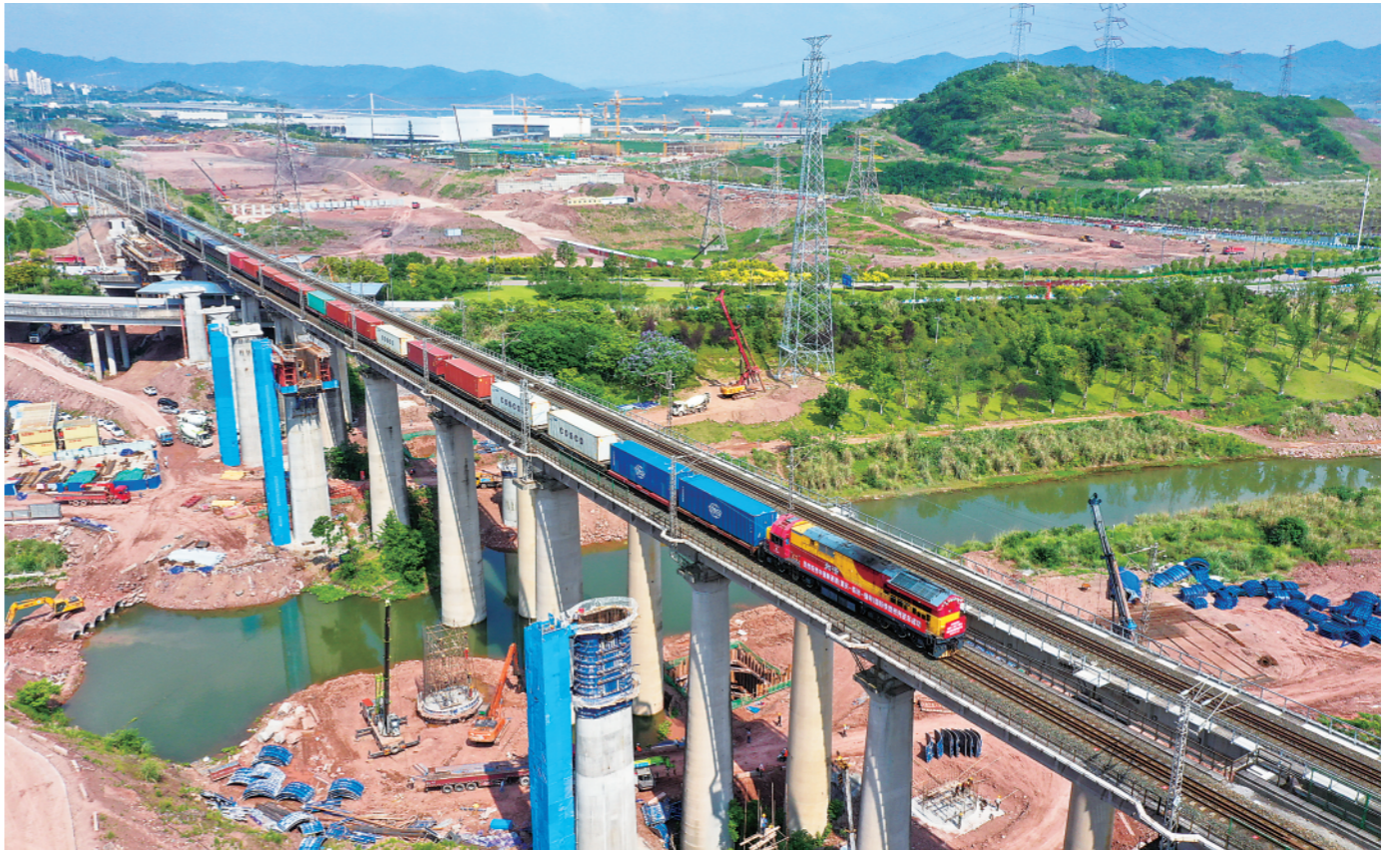
中缅新通道(重庆—临沧—缅甸)国际铁路班列从重庆果园港鱼嘴车站顺利发车(五月二十三日摄)。新华社记者唐奕摄
