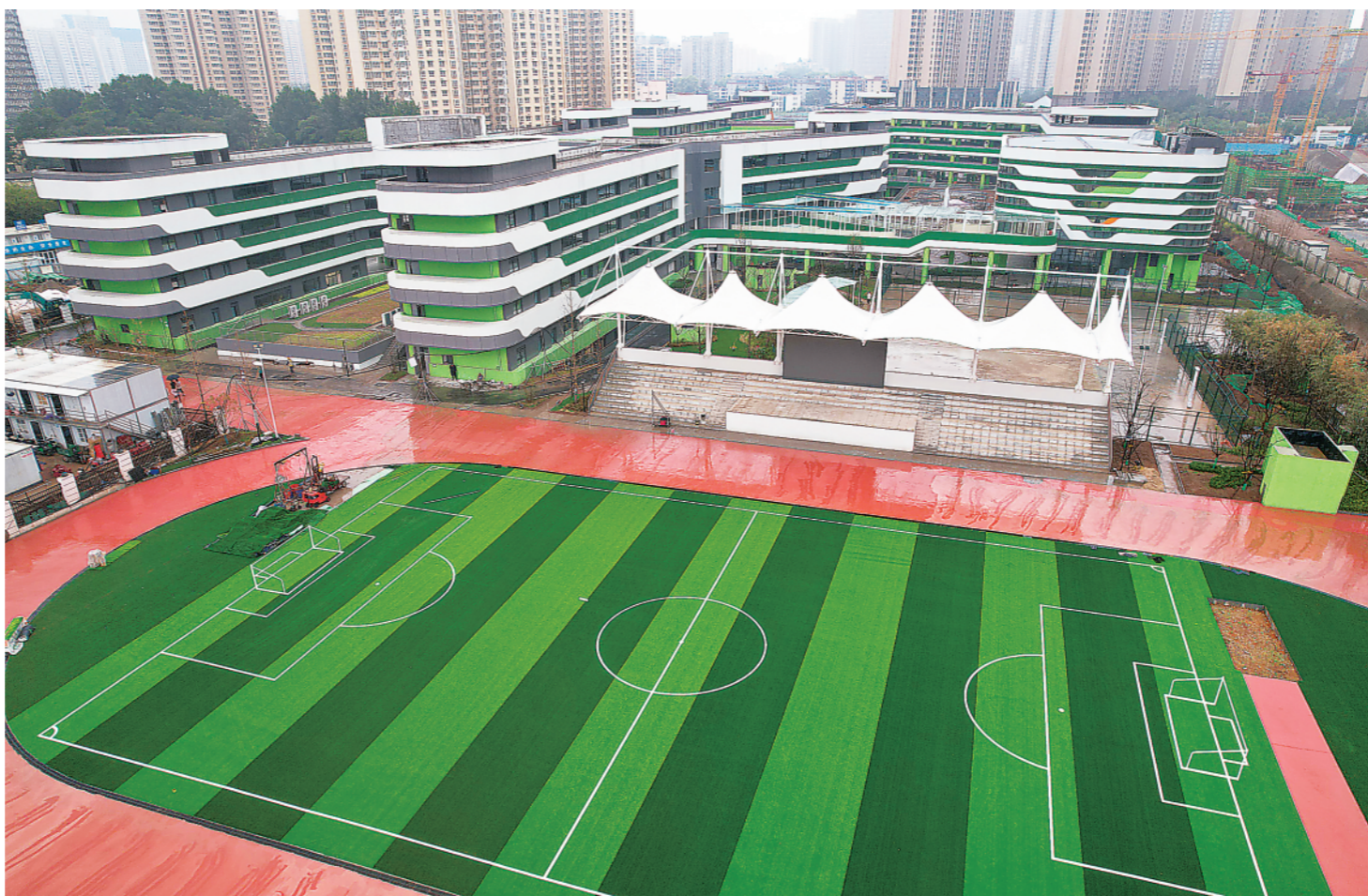
▲由中建安装华西公司承建的西安市雁塔区第一小学项目，规划24个教学班，提供1080个学位(无人机照片，8月25日摄)。今秋开学在即，陕西西安市计划投用新建、改扩建中小学和幼儿园116所，增加学位10.5万个，以满足近年来城市不断增长的学位需求。新华社记者邵瑞摄
