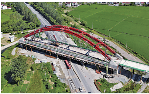
8月6日,池(州)黄(山)铁路墩上特大桥 128 米系杆拱主体工程完成施工。
