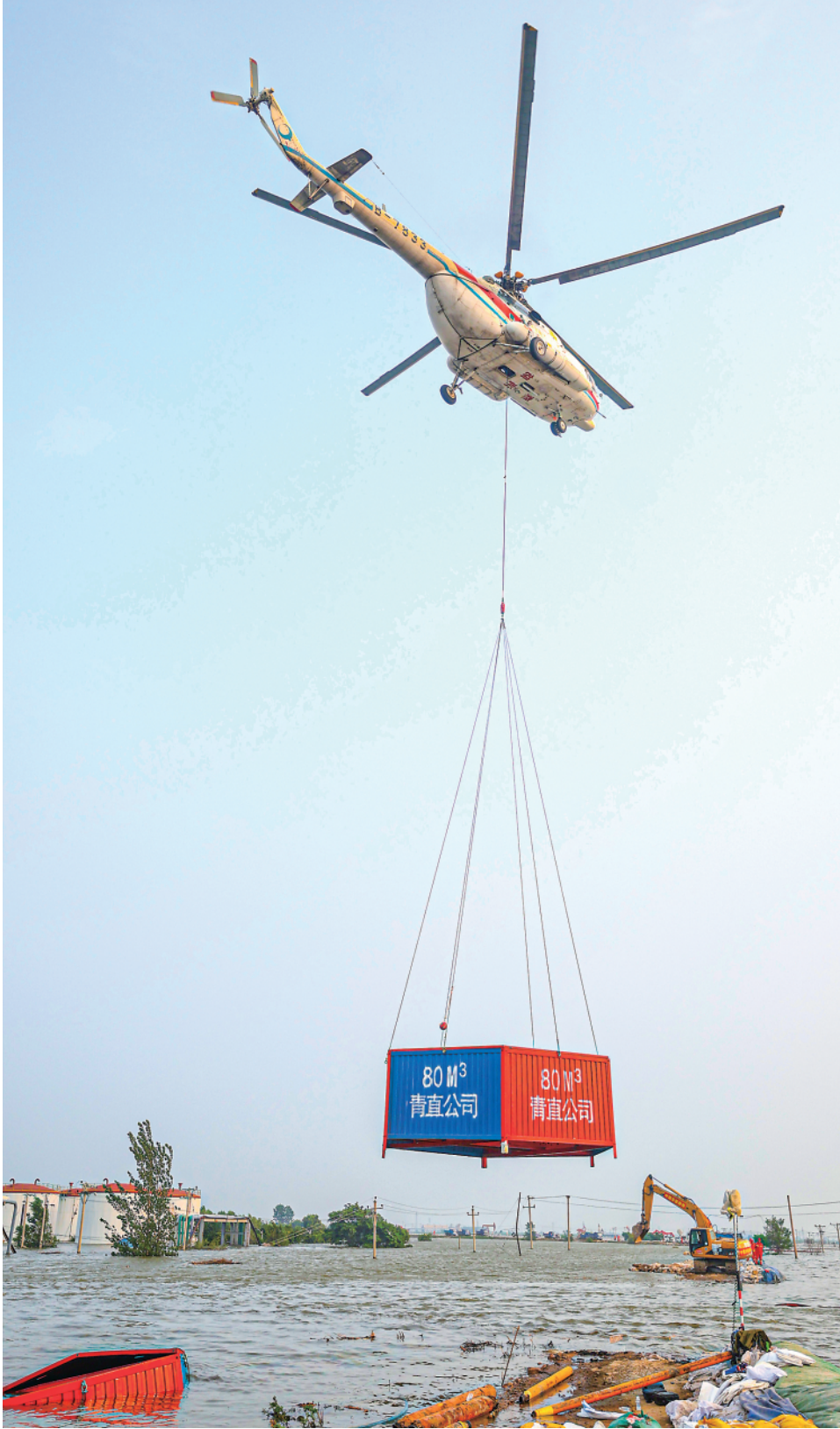
▲8月4日,直升机在溃口处投放六角沉箱。8月1日,辽宁省盘锦市绕阳河左岸曙四联段一处堤坝发生溃口。8月3日,溃口长度发展至50余米。经过各方抢险力量连日来加紧施工,抢险工作稳步推进。4日,抢险人员开始对溃口进行直升机吊装投放六角沉箱作业。
