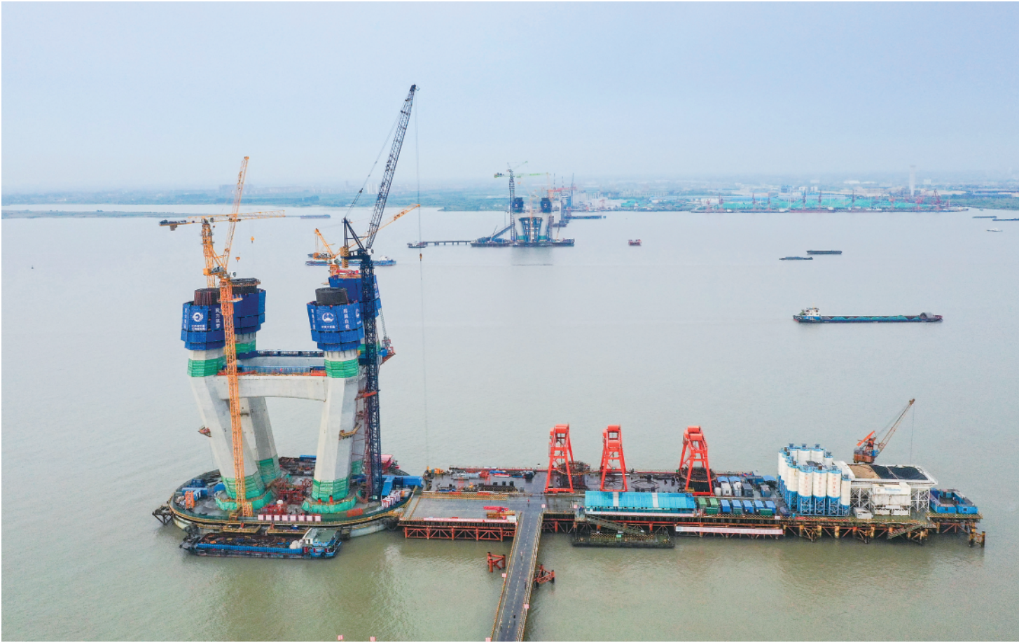
▲常泰长江大桥工程正在施工中(7月26日摄,无人机照片)。正在建设中的常泰长江大桥连接江苏省常州市与泰州市,全长10.03公里,桥梁采用上下层布置,上层桥面为双向6车道高速公路,设计时速100公里,下层桥面为设计时速200公里的两线城际铁路与设计时速80公里的普通公路,是集高速公路、城际铁路与普通公路“三位一体”的跨江大桥。 新华社记者杨磊摄
