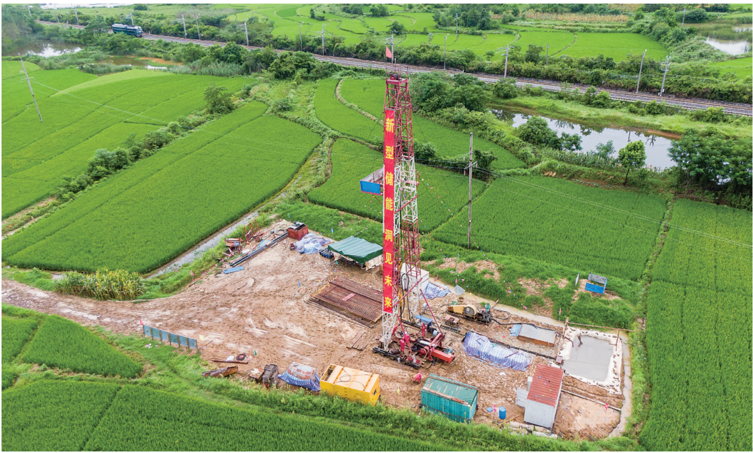
▲7月26日,工人在施工工地深层取芯,勘探地下地质条件(无人机照片)。当日,中国能建与国家电网共同投资的我国首台(套)300兆瓦级压缩空气储能示范工程开工仪式。预计工程建成后年发电量可达5亿千瓦时,其采用中国能建自主研发的大容量非补燃高压热水储热中温绝热压缩技术,核心技术指标能源转换效率达70%。 新华社记者伍志尊摄
