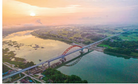
7月18日,轨道铺设顺利通过常(德)益(阳)长(沙)铁路控制性工程资水特大桥,为铁路早日通车奠定基础。新华社记者陈思汗摄
