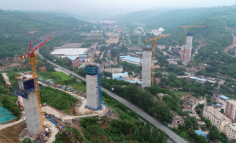
7月15日,西(安)延(安)高铁王家河特大桥主墩封顶。西延高铁是包(银)海高速铁路通道的重要组成部分。 新华社记者张博文摄
