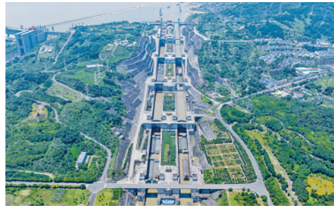
7月8日,船舶有序通过三峡五级船闸。今年上半年,三峡枢纽通过量创三峡枢纽半年通过量历史新高。新华社发(郑家裕摄)
