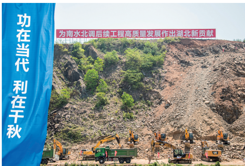
▲两图均为7月7日拍摄的引江补汉工程开工现场。
