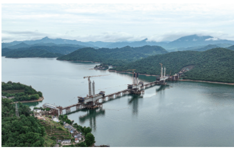
近日,池(州)黄(山)铁路太平湖特大桥第三个主塔完成封顶施工,标志着大桥三个主塔全部封顶。 新华社发(翁小虎摄)
