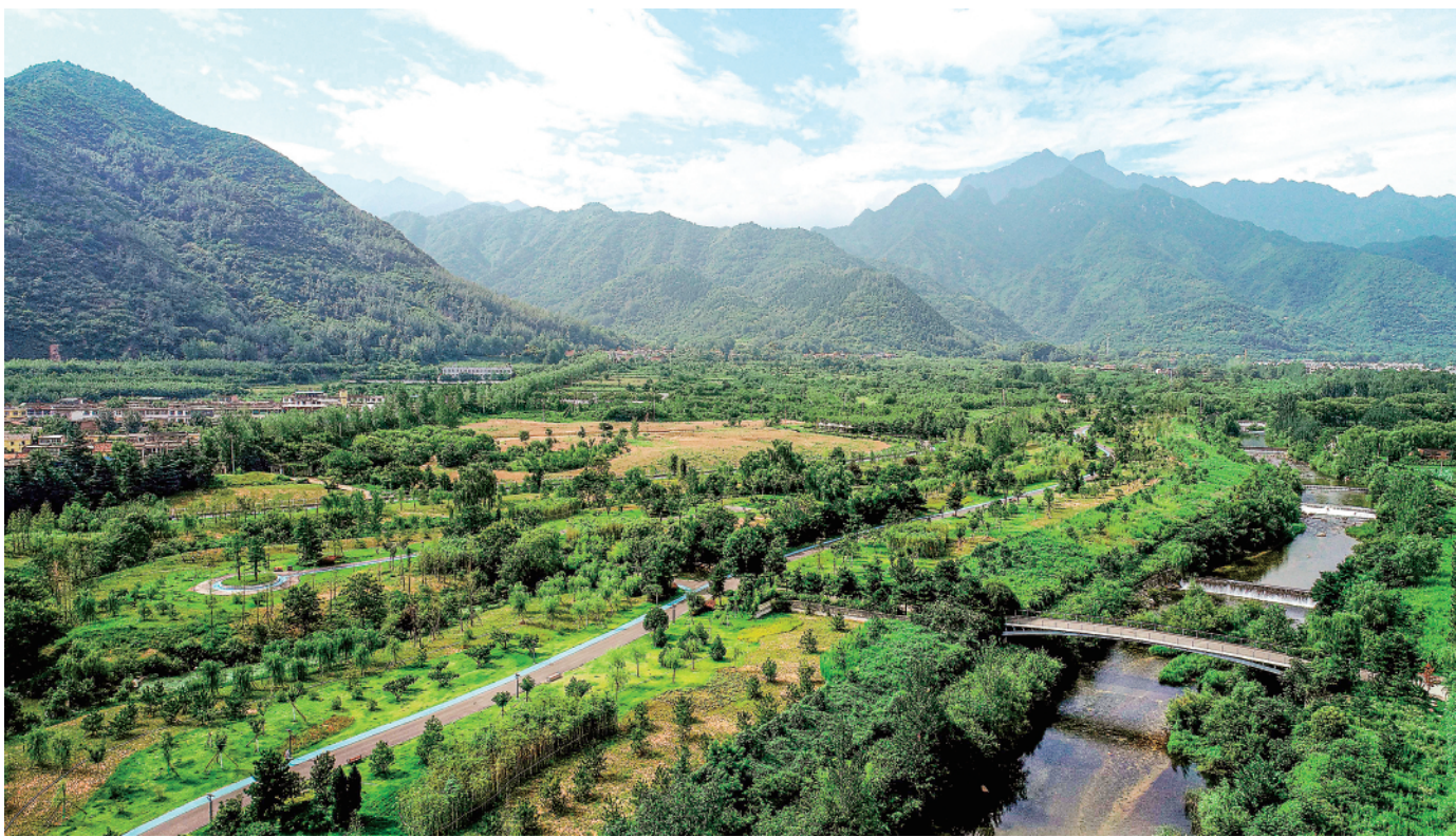
▲这是2019年7月26日拍摄的陕西省西安市长安区秦岭违建别墅拆除后建设的秦岭和谐森林公园(无人机照片)。曾经,秦岭北麓违建别墅犹如块块疮疤,蚕食着秦岭山脚的绿色。习近平总书记先后6次作出重要指示批示。中央派出专项整治工作组入驻陕西,千余栋违建别墅被彻底整治并复绿。
