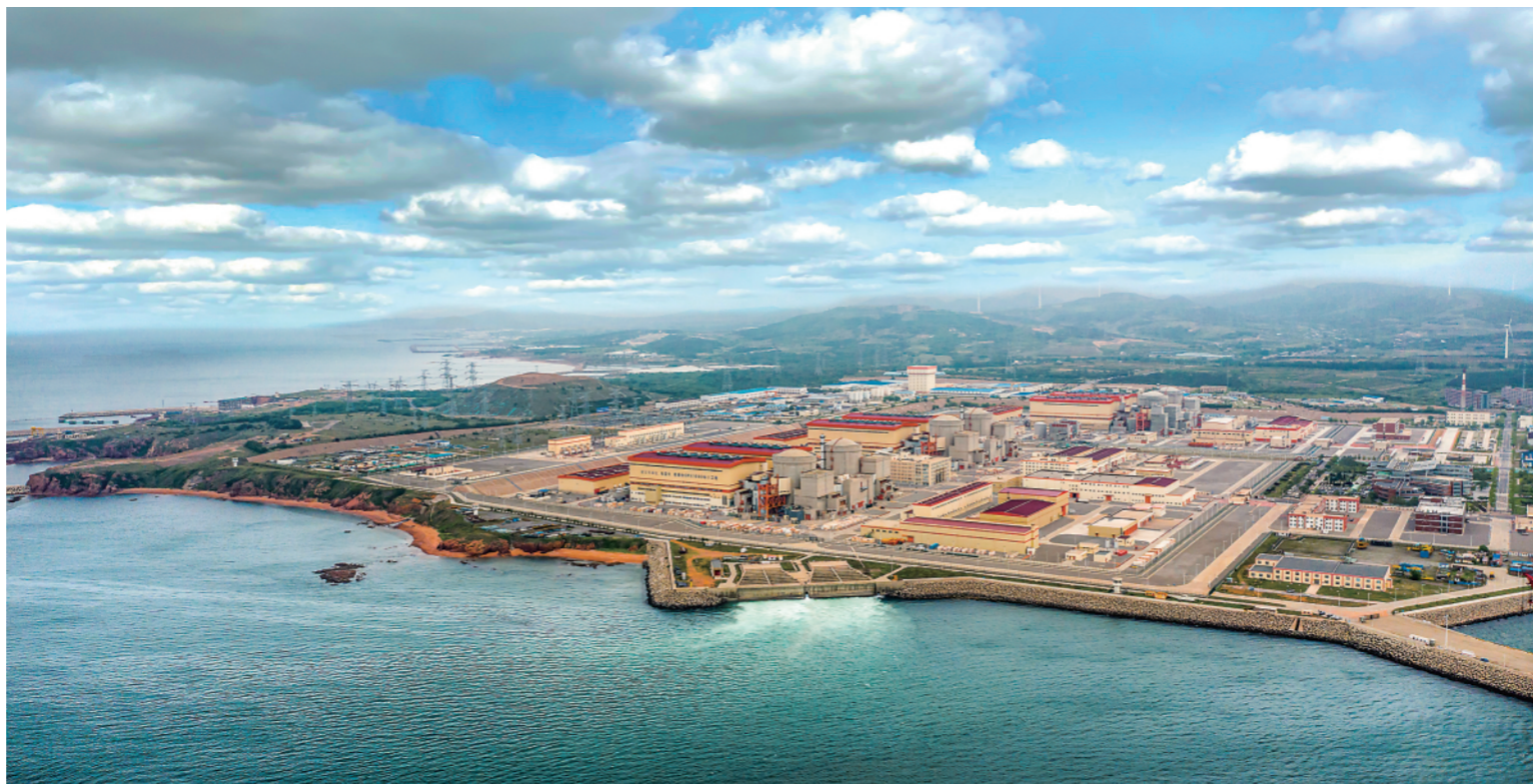
▲图为辽宁红沿河核电站。
