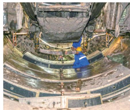
▲建设者进行管片拼装作业(6月20日摄)。6月21日,中铁五局承建的国家重点水利工程项目滇中引水工程龙泉倒虹吸盾构段顺利贯通。
