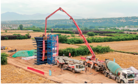
6月9日,西(安)十(堰)高铁沪河特大桥13号桥墩顺利完成浇筑。新华社记者李一博摄
