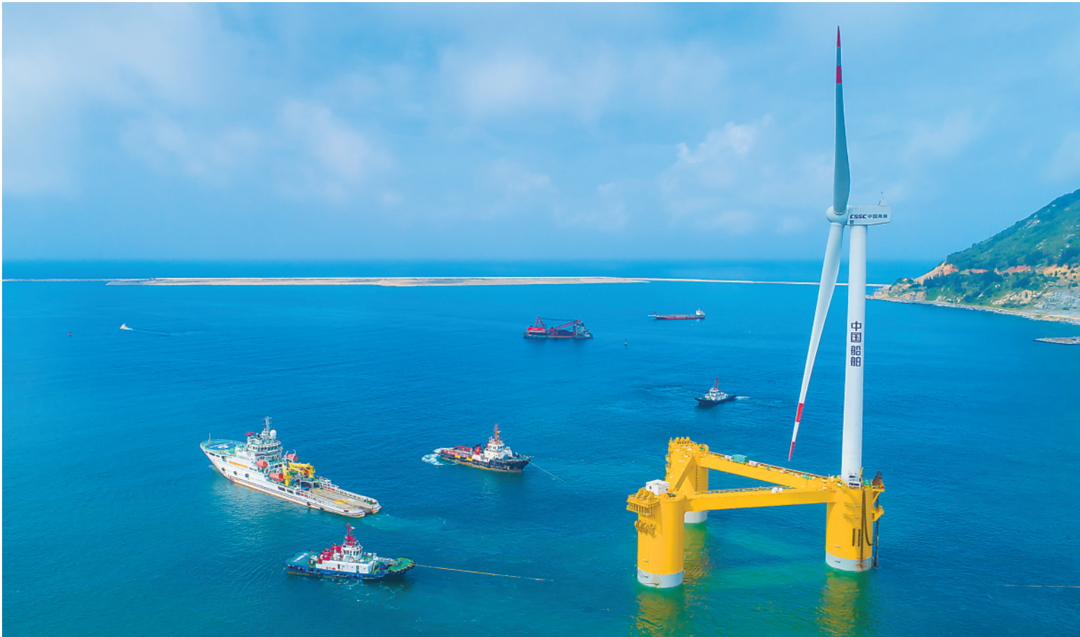
▲5月29日，国内首台深远海浮式风电装备“扶摇号”在广东茂名广港码头拖航，将前往平均水深达65米的广东湛江罗斗沙海域进行示范应用。由中国船舶集团海装风电股份有限公司牵头，联合相关单位自主研制的“扶摇号”浮式风电机组浮体平台上配备6.2兆瓦抗台型1类风力发电机组，在深远海应用场将依靠九个对称分布的悬锚链系泊实现固定。 新华社记者刘大伟摄
