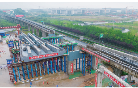
5月29日，长沙磁浮东延线接入T3航站楼工程道岔梁顶推施工启动，为工程如期建成运营奠定基础。 新华社记者陈思摄
