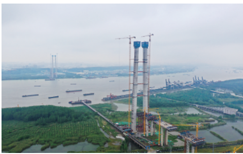
近日，南京仙新路过江通道主桥主塔全部封顶，工程下一步将进入主桥索梁施工阶段(5月26日摄)。 新华社记者季春鹏摄
