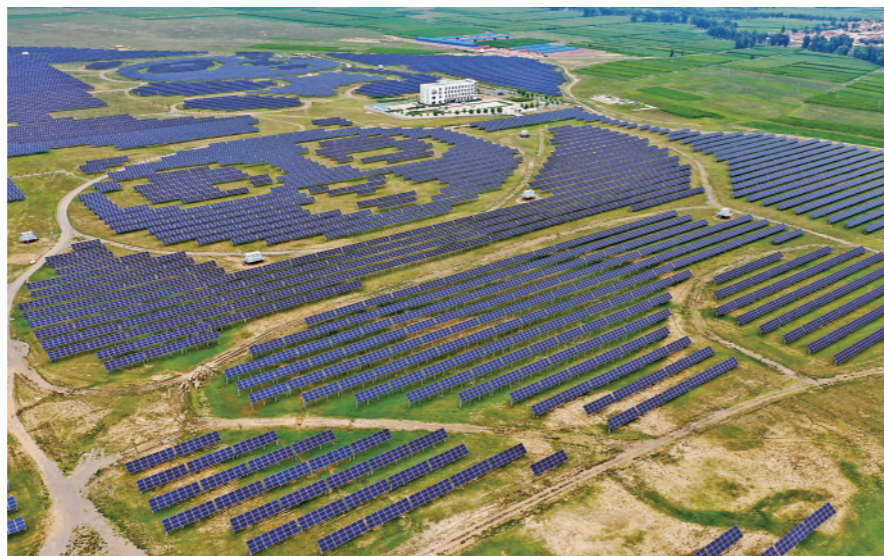
位于大同市以大熊猫为造型的光伏电站。新华社记者曹阳摄
