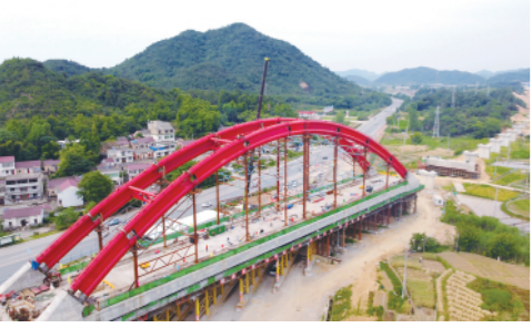
近日,池(州)黄(山)铁路白沙铺特大桥系杆拱顺利合龙。池黄铁路是武杭快速铁路通道的重要组成部分。新华社发(成忠摄)
