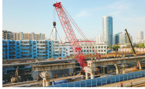
近日,济(南)郑(州)高铁引入济南枢纽工程京沪联络上行线北—北高架特大桥桥梁吊拆施工完成。新华社记者郭绪雷摄
