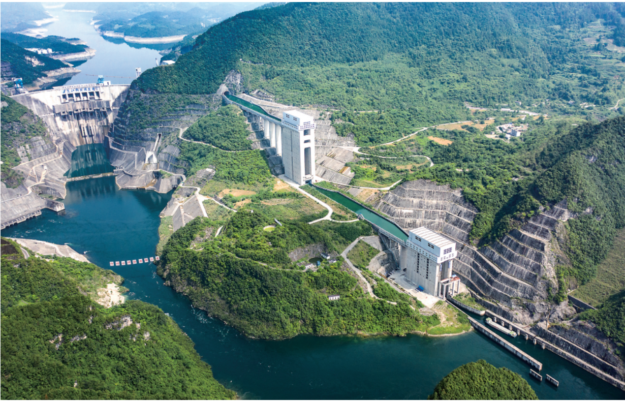
▲500吨级标船从遵义市构皮滩水电站通航工程下游引航道驶入第三级承船厢(2021年6月22日摄)。
