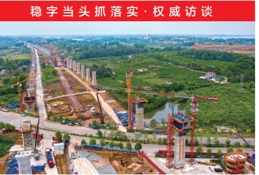
▲施工人员在荆荆高铁荆门特大桥进行连续梁施工作业(4月27日摄)。目前,湖北荆(门)荆(州)高铁已全面进入上部结构施工阶段。新华社发(徐云华摄)
