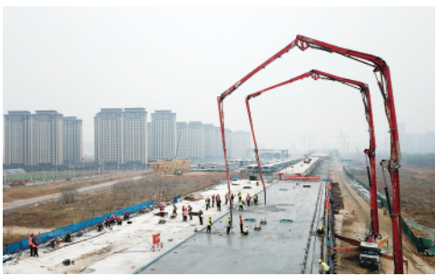
近日,济(南)莱(芜)高速铁路历城站特大桥道岔现浇梁浇筑完成,为后续施工奠定坚实基础(3月16日摄)。 新华社记者郭绪雷摄
