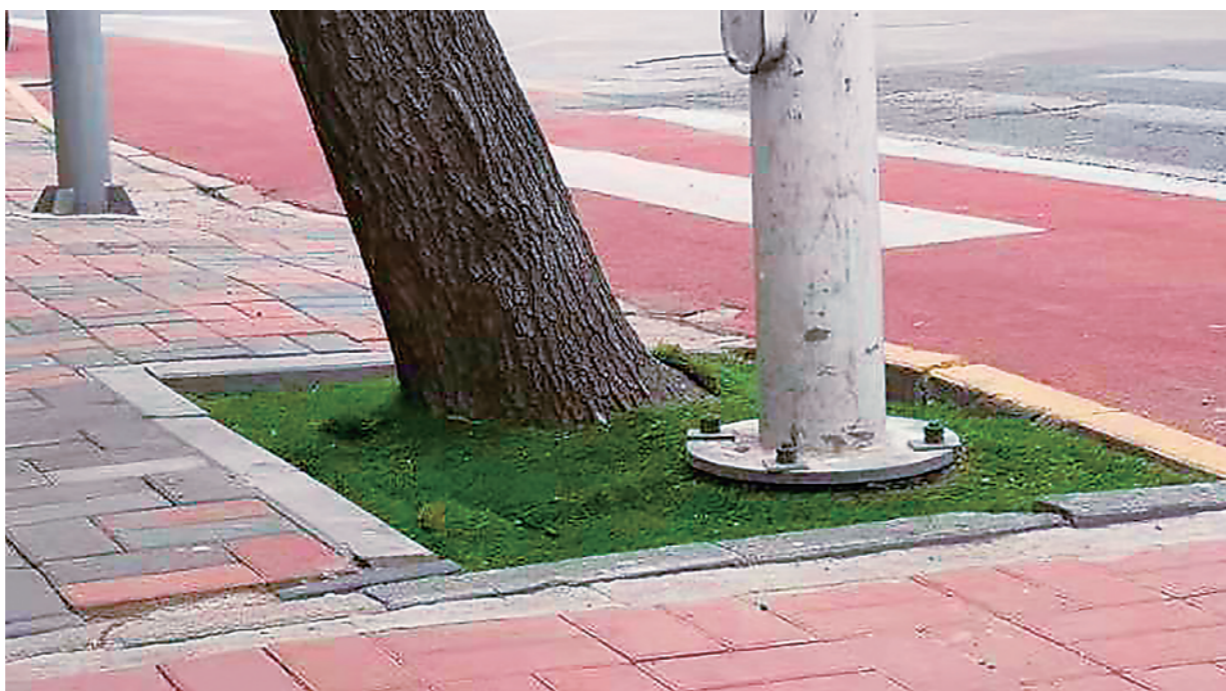
灯杆安装在树坑中。
