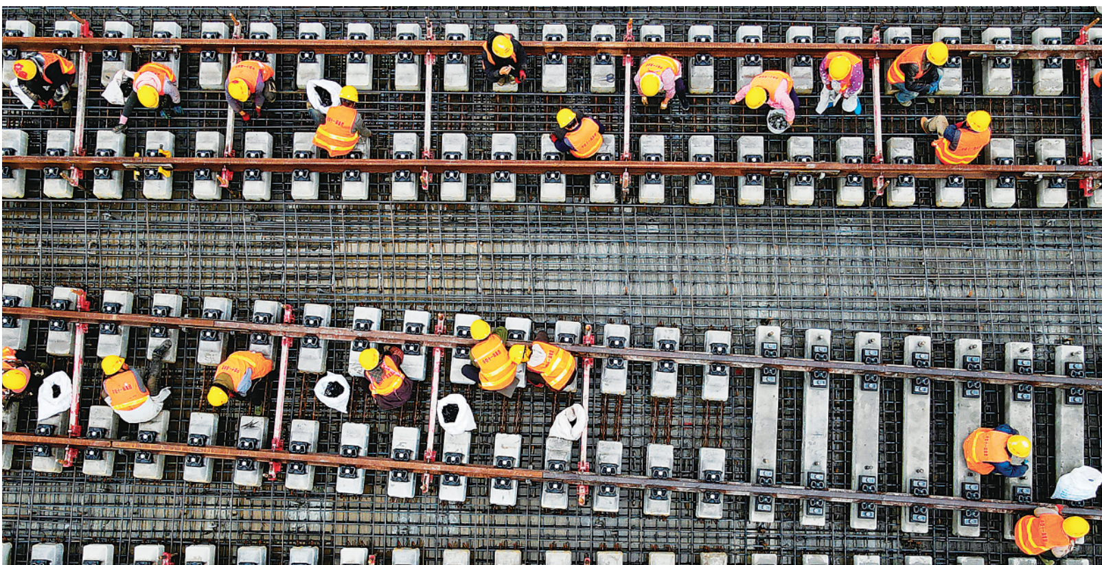
▲在新建福厦铁路莆田站无砟轨道施工现场，工人们抓紧施工(无人机照片，1 月 23 日摄)。
