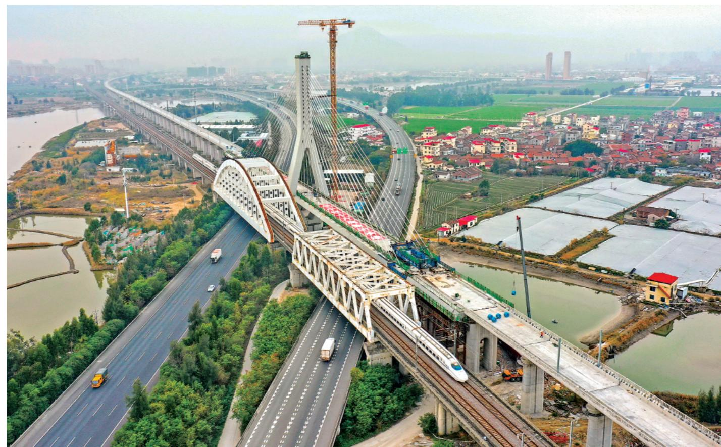
新建福厦铁路木兰溪特大桥斜拉桥主梁合龙
