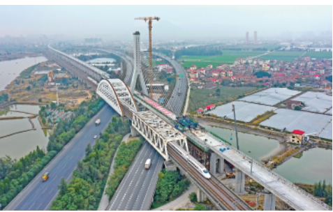
1月16日,中国首条跨海高铁——新建福(州)厦(门)铁路木兰溪特大桥斜拉桥主梁顺利合龙。 新华社记者林善传摄
