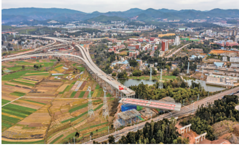
1 月 12 日,云南玉(溪)楚(雄)高速公路小郭邑特大桥顺利完成 90 度转体,成功上跨广(通)大(理)铁路。
